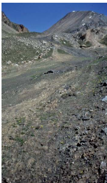
Nivellements pour pistes de ski (Unterrothorn VS)
