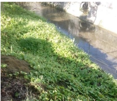
Berge d'un cours d'eau envahi
